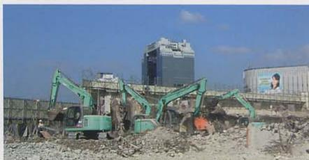
階上に載せられた解体機がビル躯体を破碎しながら下りていく、いわゆる階上解体作業。その現場ではいまコストと時間の制約か
